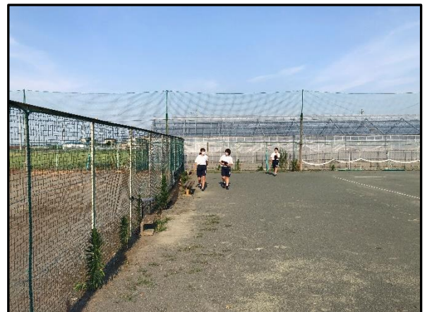
フェンス確認
