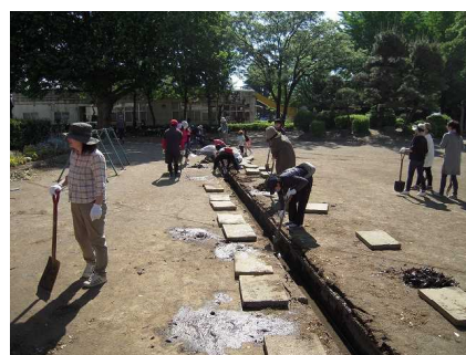
【側溝清掃の様子】
