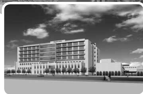
館林厚生病院耐震化工事
