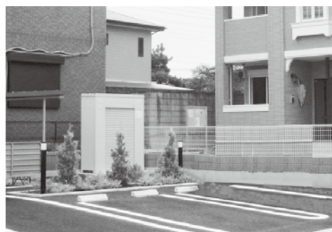
アパートなどの外構、駐車場舗装、自転車置き場なども申告の対象です
