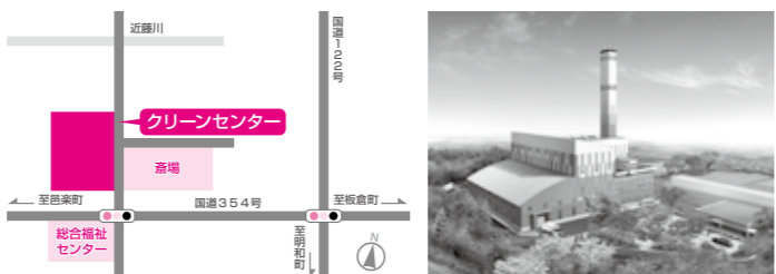
○たてばやしクリーンセンター・焼却施設 (可燃ごみ)
