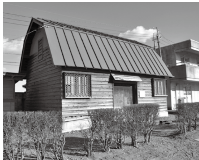
館林高校の校庭東側に現存している旧銃器庫
