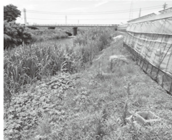
現在の青柳橋(奥)と旧青柳橋の欄干跡(右下)
