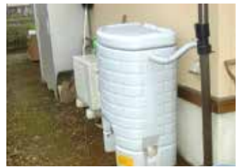
雨水貯留槽
