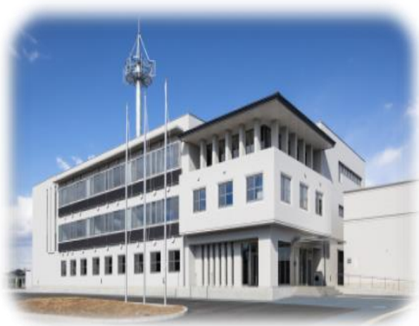
『消防本部兼館林消防署』
