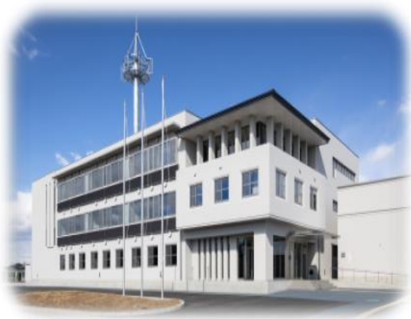
『消防本部兼館林消防署』
