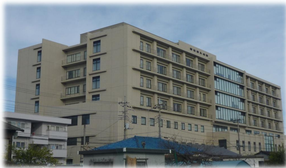
『館林厚生病院新本棟』
