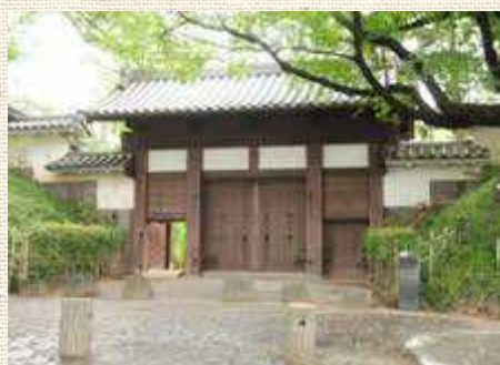
館林城跡（土橋門）
