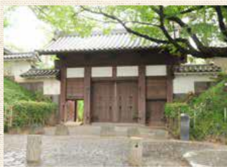
館林城跡（土橋門）
