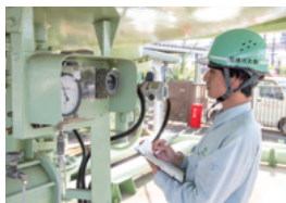
構内の安全点検を行います
