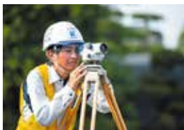
現場では作業員への指示のほか測量も行う
