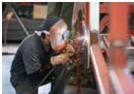
キャリアカーの部品を溶接して組み立てます
