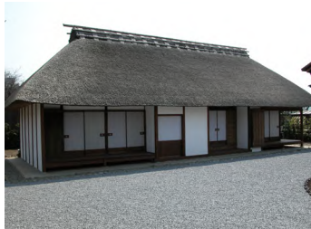
旧館林藩士住宅（武蔵館）
