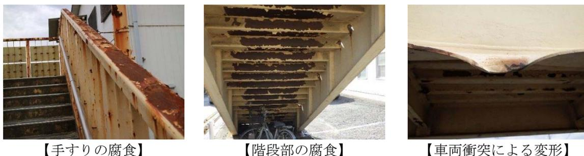
図3 損傷事例
