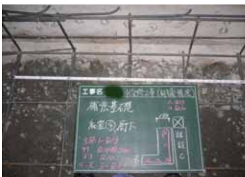
基礎増打部分配筋状況
