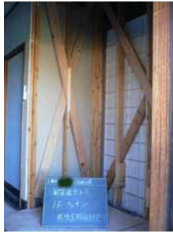
キッチン・施工状況 (筋かい取付)
