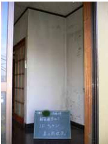
キッチン・施工前
