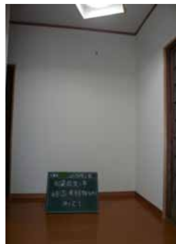
1F和室・施工完了 (内装工事完了)
