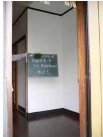
キッチン・施工完了 (内装工事完了)
