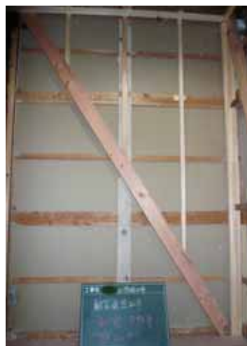
1F和室・施工状況 (筋かい取付)
