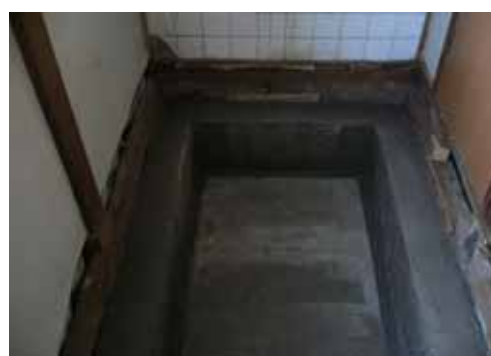
基礎増打部分コンクリート打設完了
