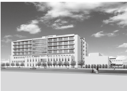
館林厚生病院新病棟
