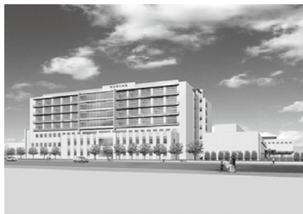
館林厚生病院新病棟
