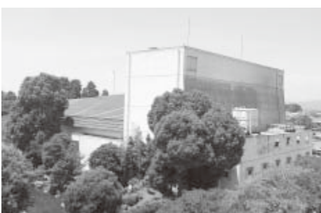
改修工事が予定されている文化会館大ホール棟
