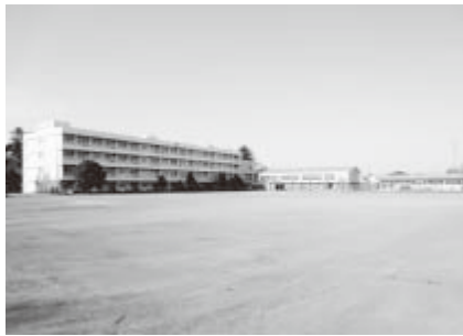
耐震改修工事を実施した“多々良中学校”
