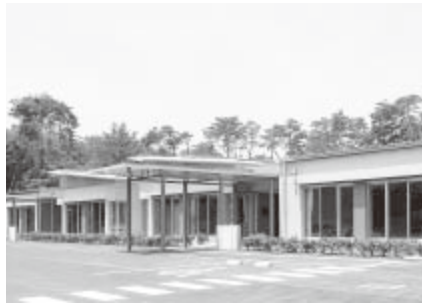
完成した“障がい者総合支援センター”
