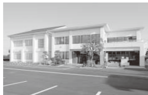
増築工事が完了した“渡瀬公民館”
