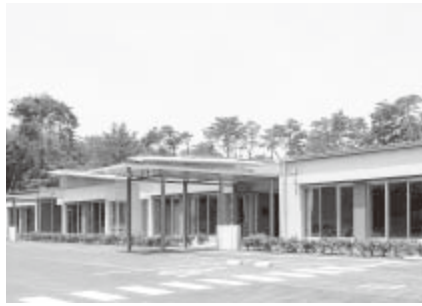
完成した“障がい者総合支援センター”
