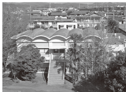
4月より館林支所となる第一浄水場
