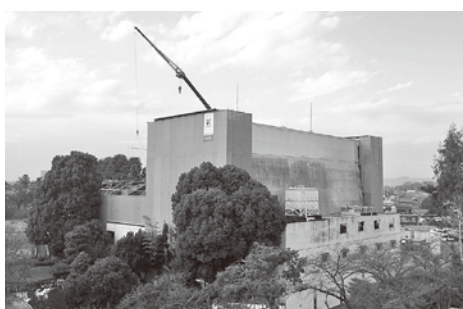
改修工事が行われている文化会館
