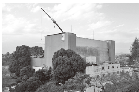
改修工事が行われている文化会館
