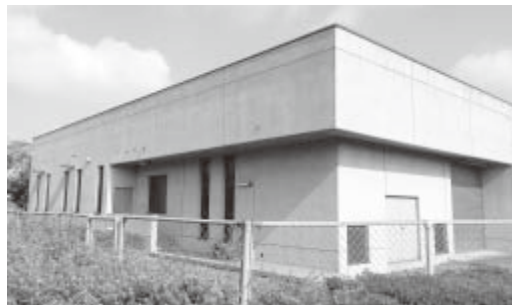
尾曳汚水中継ポンプ場
