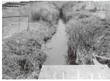
岡野幹線排水路
