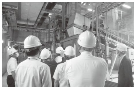
水質管理センターの現地調査
