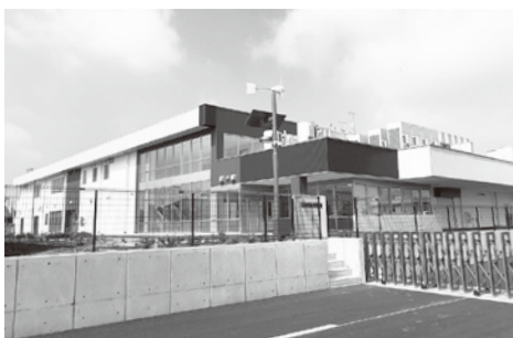
建設中の学校給食センター
