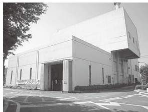
解体される清掃センター
