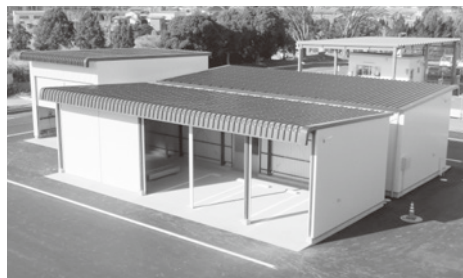
清掃センター焼却施設跡地に整備されたたてばやしストックヤード
