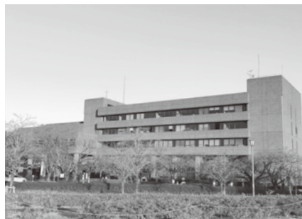
耐震改修工事が行われる市役所庁舎
