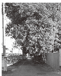
道路にはみ出した樹木
