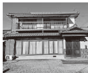
実際の空き家の様子
