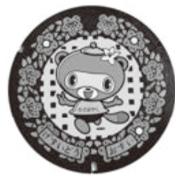
マンホールの蓋
