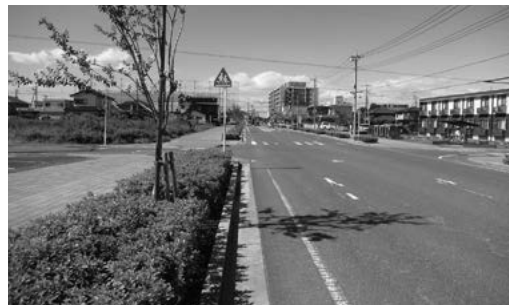
植栽工事が実施された駅西通り線(栄町)
