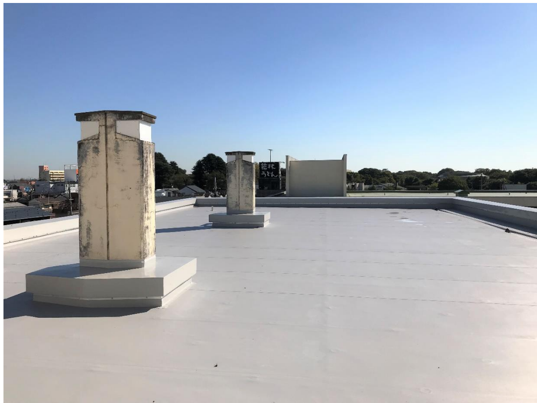
屋根③（今年度改修後）
