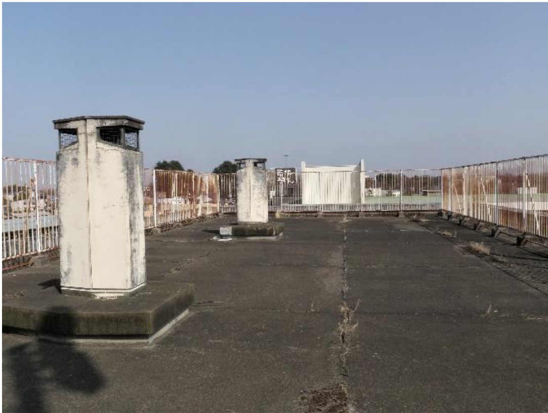
屋根③（今年度改修前）
