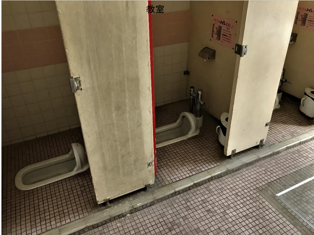
トイレ（改修前）
