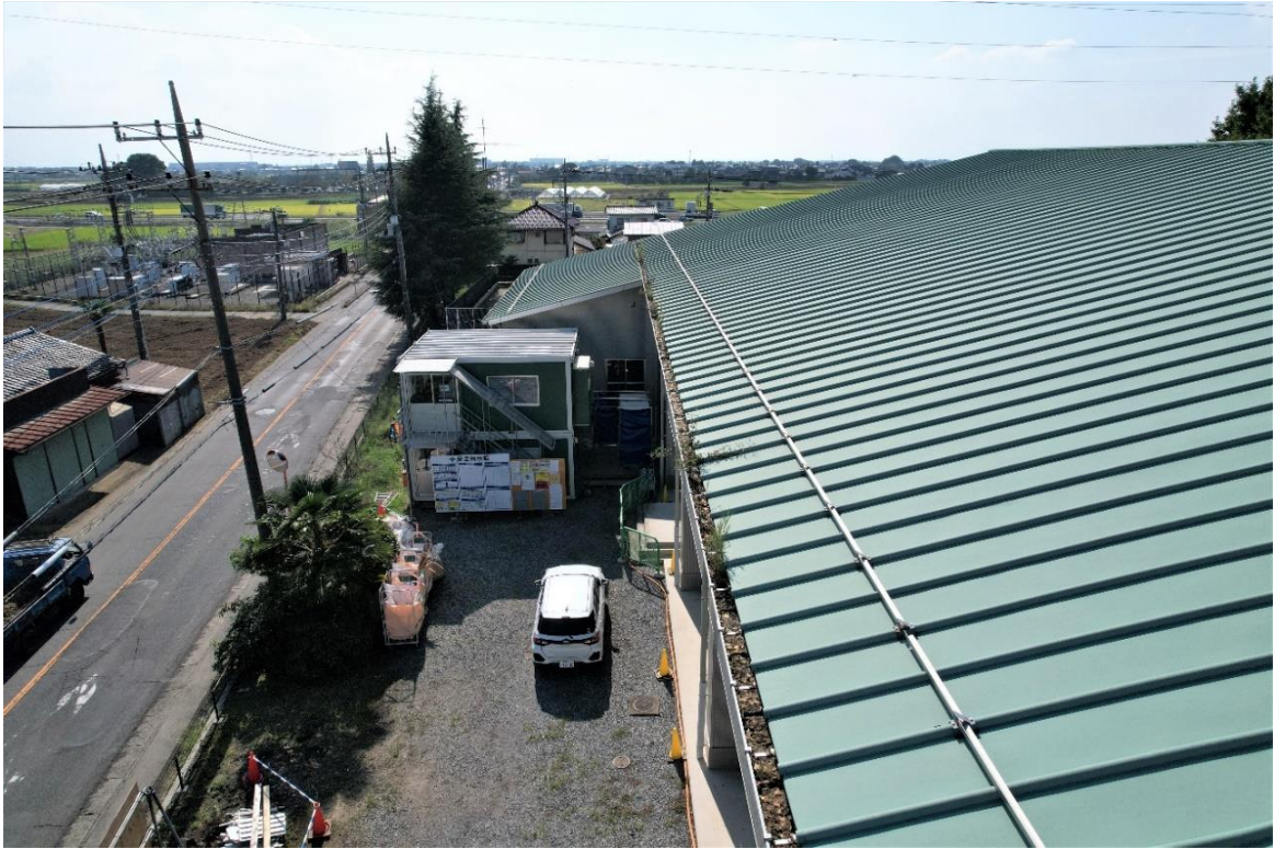
雨樋①（ドローンによる撮影）
