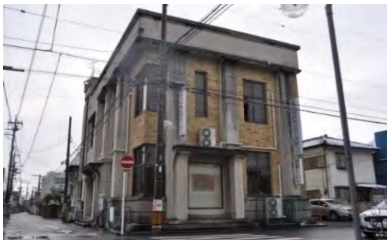
写 5-6 旧館林信用組合（現市民センター分室） 仲町・昭和9年（1934）建築
