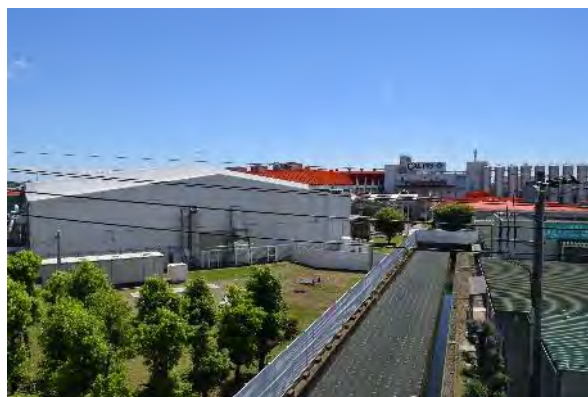
写 3-6 工業団地（渡瀬工業団地）
