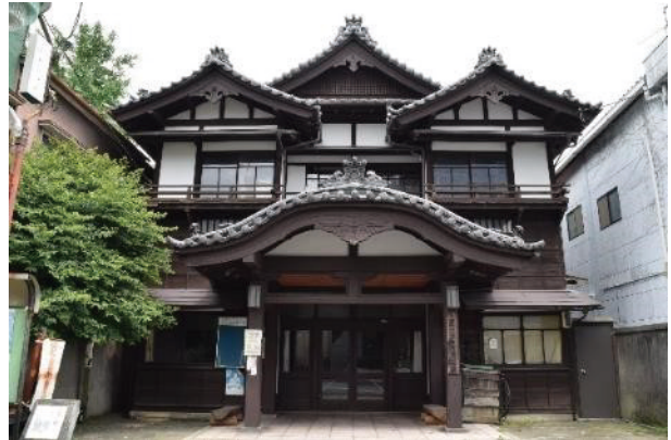
写 6-24 旧館林二業見番組合事務所
