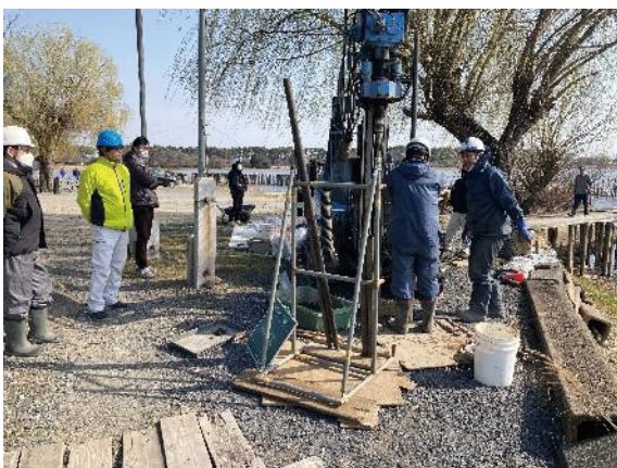
写 6-11 多々良沼遺跡ボーリング調査
