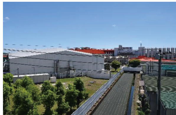
写 2-31 工業団地(渡瀬工業団地)
