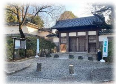
写 6-20 館林城跡・三の丸土橋門
