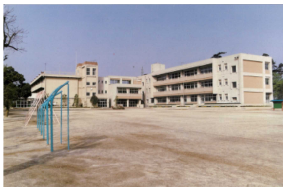
A棟完成直後(S59.03)
