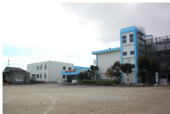
着々と進行する外壁工事 (R5. 12)
