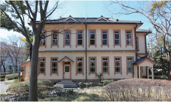
旧上毛モスリン事務所東面
