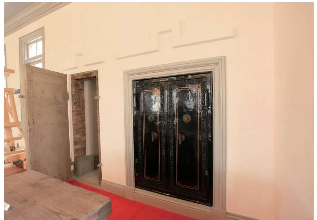
旧上毛モスリン事務所 1階内部 (耐火金庫と書庫入口)
