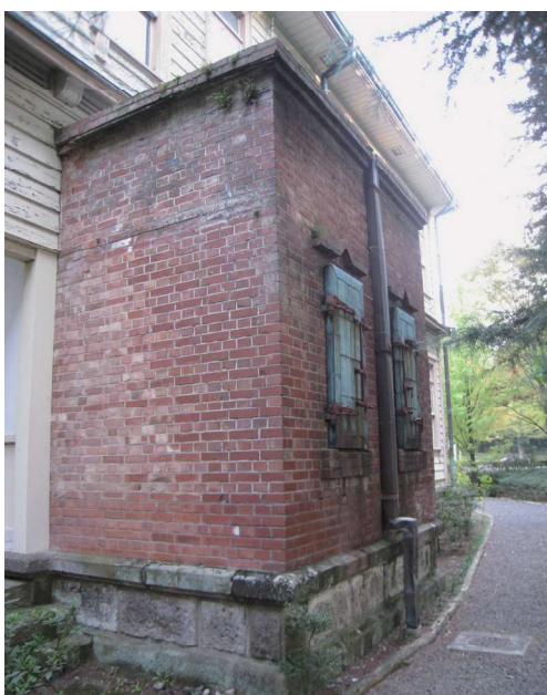
旧上毛モスリン事務所 煉瓦造の耐火金庫・書庫
