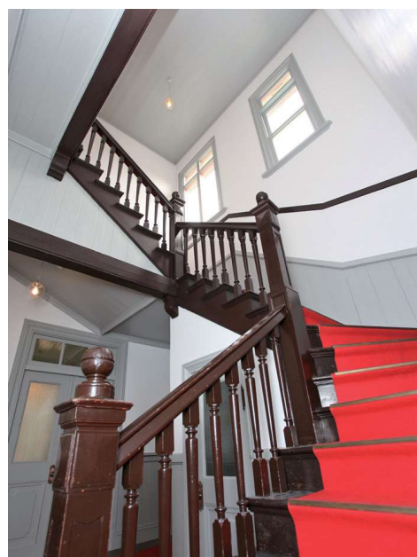
旧上毛モスリン事務所 階段 (空中中折れ階段)
