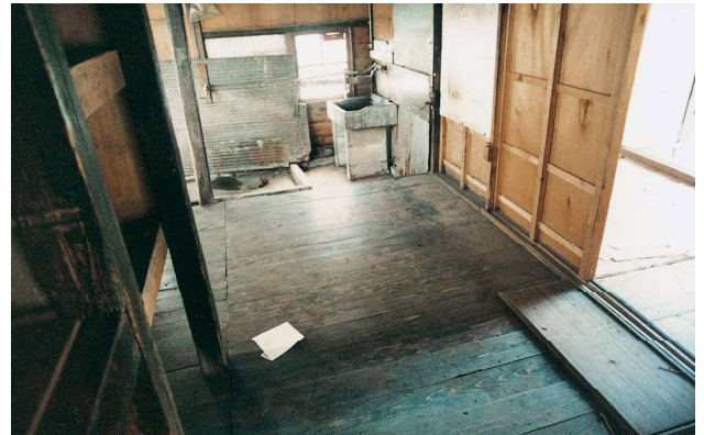
解体前の台所
