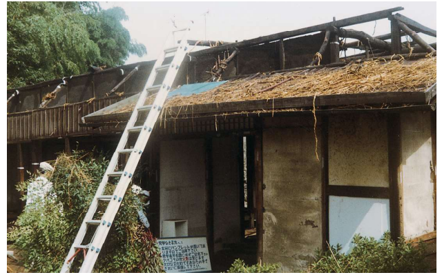
解体中の田山花袋旧居 (屋根の茅を降ろしたところ)
