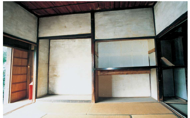
解体前の奥の座敷 (八畳)
